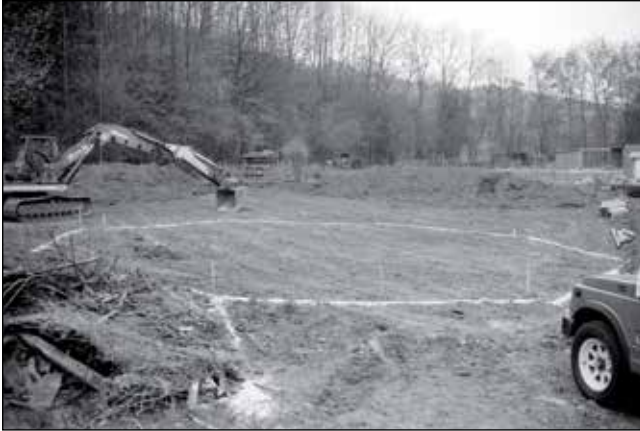
Bauplatz im Eigental am Wiesbach
